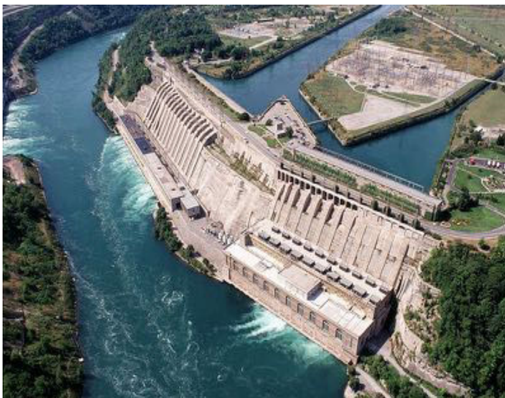
Le complexe hydroélectrique Sir Adam Beck à Niagara Falls
