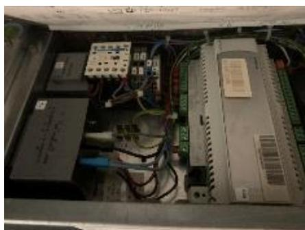
Ils offriront une protection mécanique minimum IP30. Ils devront pouvoir être équipés de base de cache-borniers et de passe-câbles permettant un montage en faux plafond sans utilisation d'une enveloppe additionnelle.
